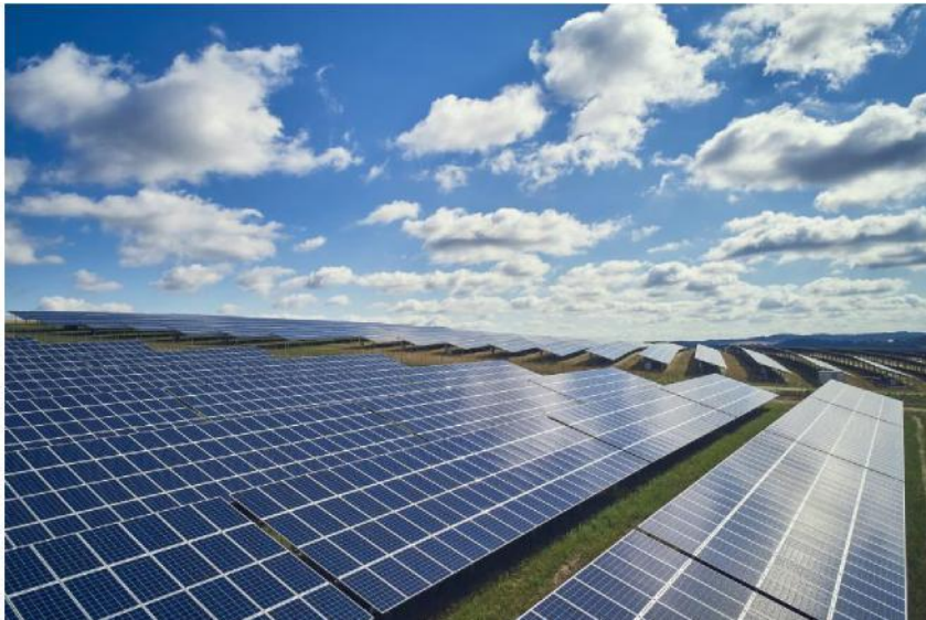
Abbildung 1: Beispiel für eine Freiflächen-Photovoltaikanlage
