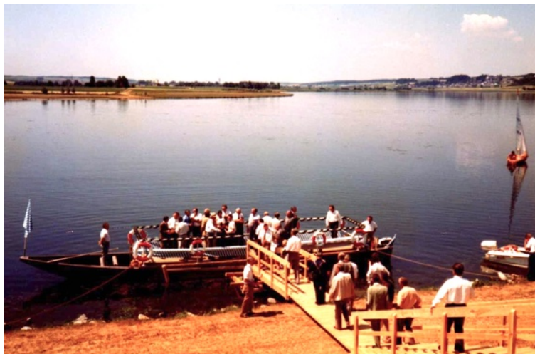
Über einen provisorischen Steg starteten die Gäste der Eröffnung vom Damm aus am 8. Juli 1976 eine Bootsfahrt.
