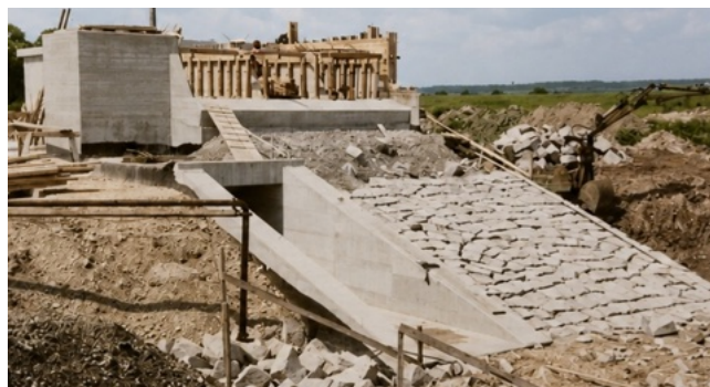
1974: Schöpfwerk für den Ortsdeich im Bau
