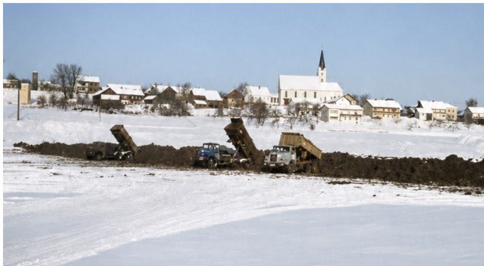
Von Nov. 1972 bis Anfang 1975 wurden große Mengen an Material bewegt.
