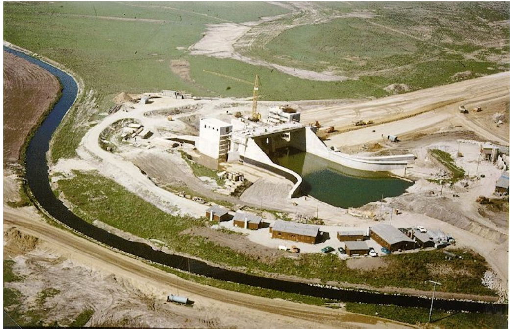
Vorübergehend legte man die Vils in ein neues Bett, den alten Verlauf verfüllte man im Bereich des späteren Grundsees (oben). Temporär entstanden Bauhütten nahe des Auslass- und Entlastungsbauwerks und eine Baustraße nach Armöd (unterer Bildrand, von dort wurden Kies und Lehm herangefahren). Betonarbeiten am Auslassbauwerk (Mitte) erfolgten in den Jahren 1972 und 1973. (Bild: WWA LA)
