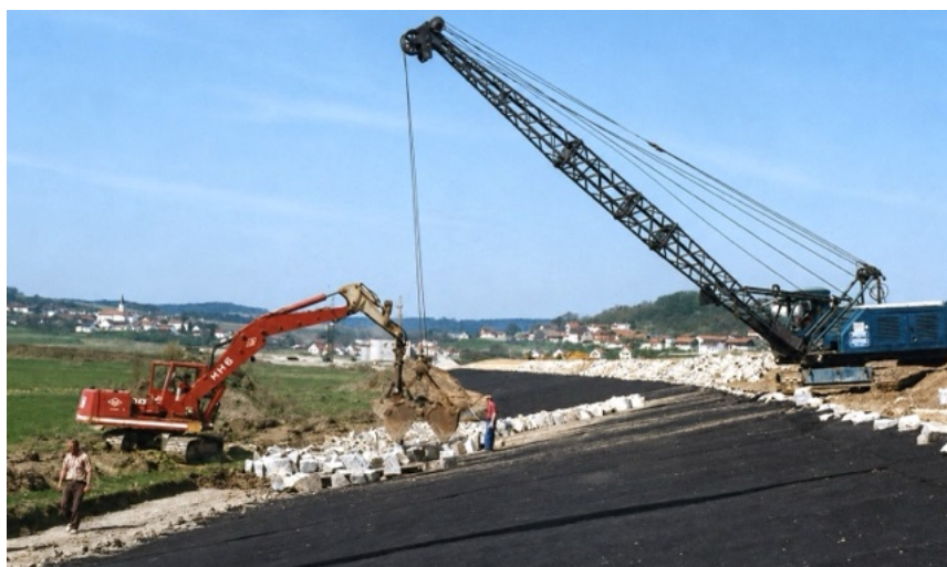
Befestigung der wasserseitigen Böschung (Blickrichtung: Steinberg-Warth).
