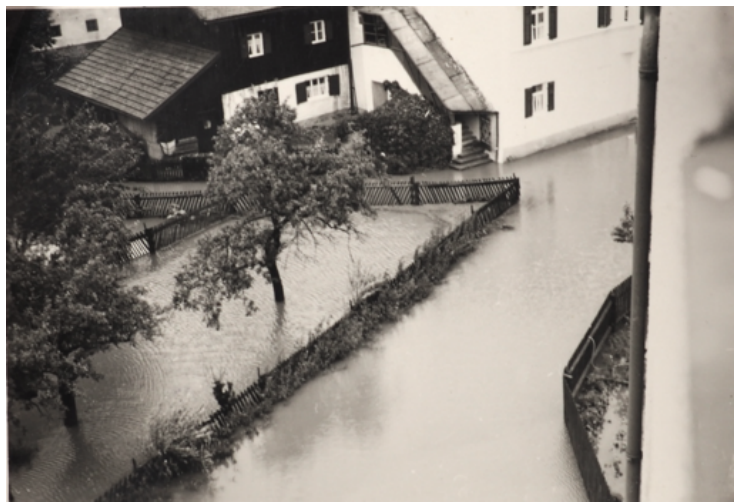
Blick von der Stegmühle aus auf die überschwemmte Brückenstraße (beide Fotos: Sammlung Irmgard Kiermeier)
