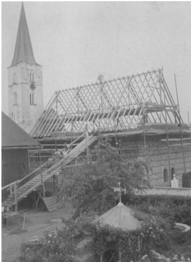
Die Bürger unterstützten den Bau tatkräftig.
