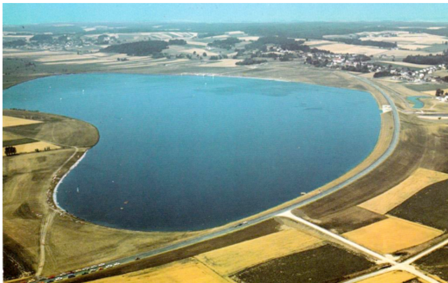
Das eben fertiggestellte Hochwasser-Rückhaltebecken Marklkofen-Steinberg zog 1976 die Wassersportler an (Foto: Aero-Express München).
